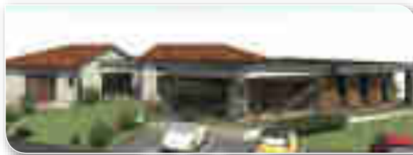
Vue façade arrière
