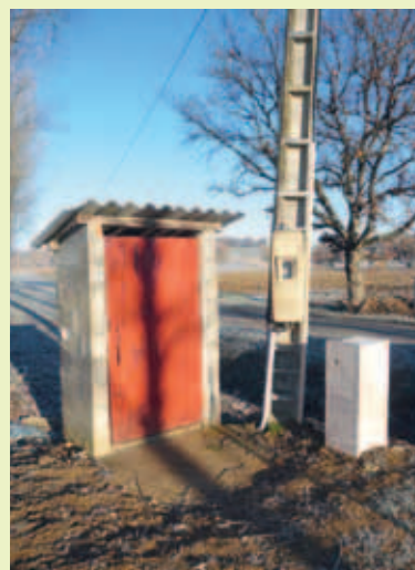
Renforcement électrique du stade et de la salle des sports
