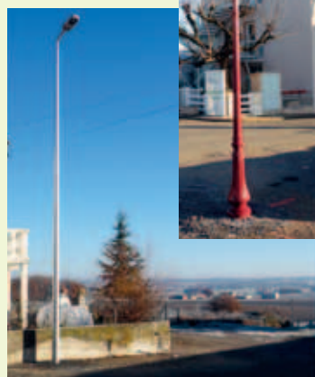
Amélioration de l'éclairage au hameau du Bouriat et à la place de l'Oulmet
